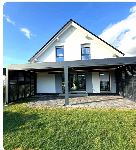
Lamellen- und Screenwand am Giebelhaus, Himmelkron
