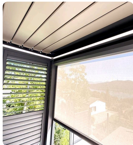
Lamellenwand und Screen in der Ecke, Wörthersee
