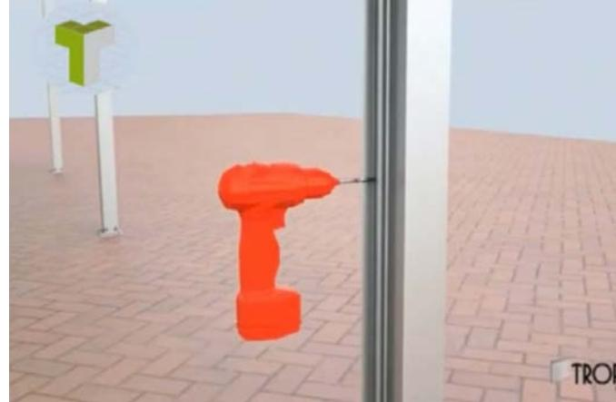
Achten Sie darauf, dass Sie die Löcher vorbohren und die Schrauben nicht überdrehen.
